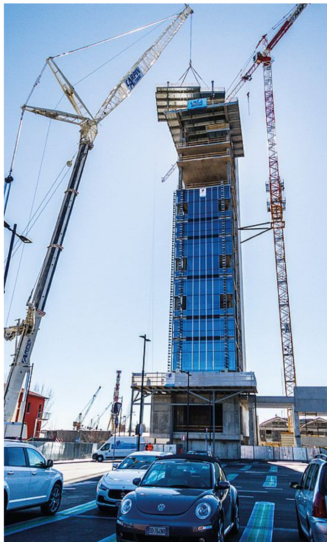
Le maxi gru che posano gli ultimi piani della struttura (foto Candussi)
